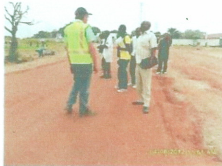
Matériau stabilisé compacté
