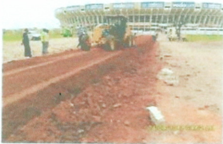
Rechargement de sable ocre de Kingakati+ Soil-fix
