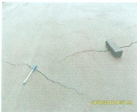
Couche de roulement de 2,00 cm au BTA
